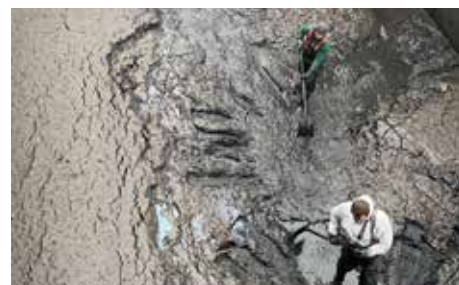
Reinigung Regenrückhaltebecken Seite 4
